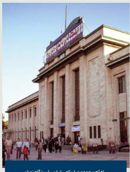
راه آهن جمهوری اسلامی ایران - ایستگاه تهران Railway of the Islamic Republic of Iran-Tehran Station موقف طهران ، سكك الجمهورية الإسلامية الإيرانية
